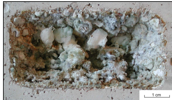
Abb.2: Teilstück einer abgetragenen Betonfläche
